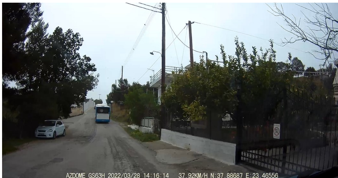
Εικόνα 5. Κακή ποιότητα οδοστρώματος (Λεωφ. Περιστεριων)
